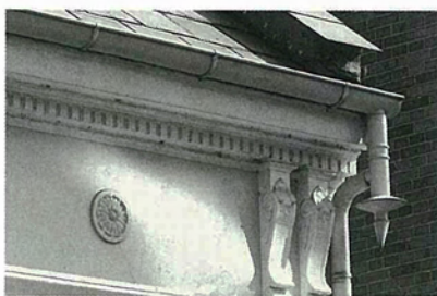
Nedløbsrør med "drueknæ".
