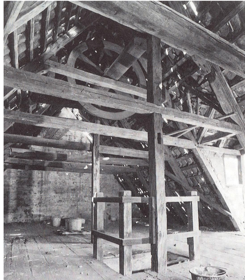
Hornebånd med svalehale og blanding fastholdt af dyvel.
