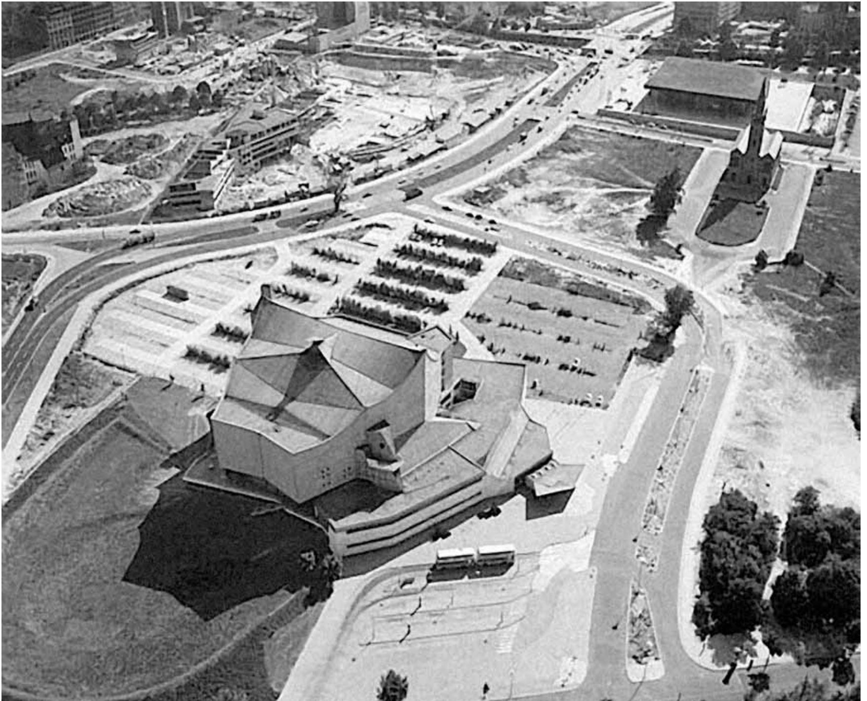
ill. 1: Oversigtsbillede 1969 (med Philharmonien i front, og Nationalgalleriet bag kirken. Stabi er påbegyndt øverst til venstre).
