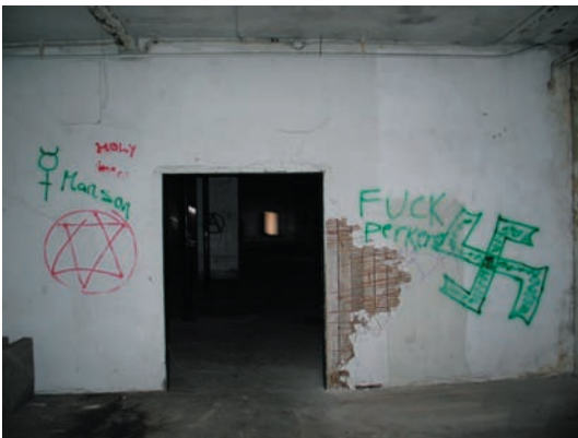
Tværgående skillevæg i den ældste produktionsfløj
