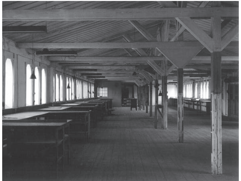
Overretagen i den ældste produktionsfløj - foto fra 1972
