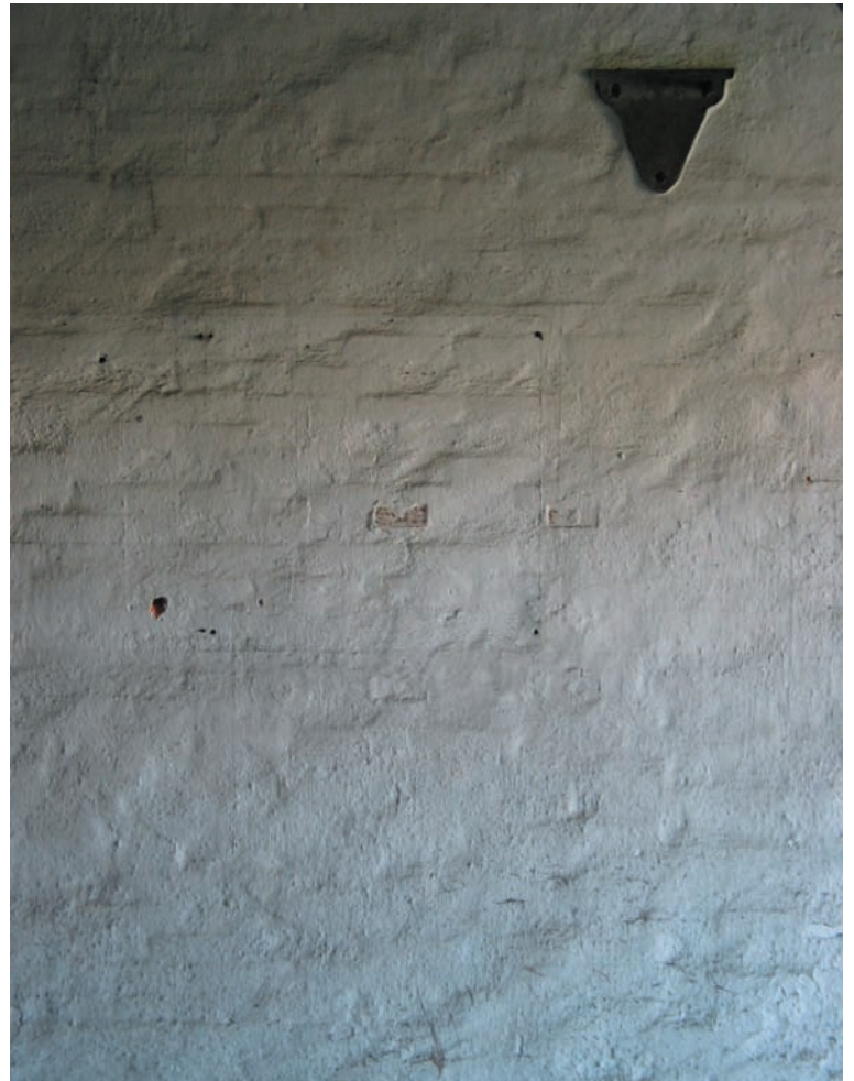
De indvendige murede vægge er nogle steder vandskurede og kalkede - andre steder pudsede. Væggene giver rummene en autentisk fabriksatmosfære og bør ikke dækkes med beklædninger eller moderniserende overfladebehandlinger
