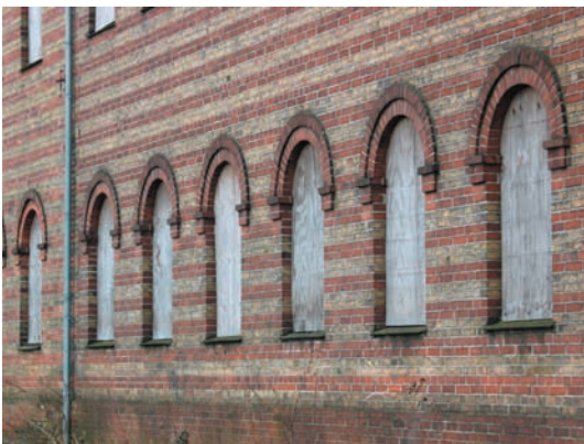
Takt og rytme præger længerne - vinduesgrupperinger er omhyggeligt disponerede
