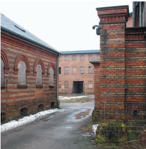
Slippen ind til det indre gårdsrum (2)
