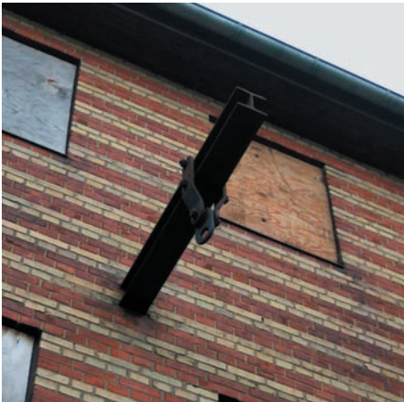
Hejsebom i stål over port er bevaringsværdig
