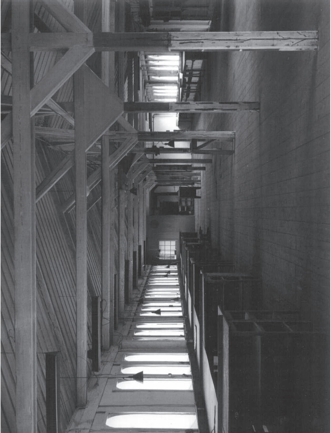
Overretagen i den ældste produktionsbygning
