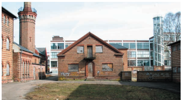
Som berigende kontrast til de højere produktionsbygninger ligger den lavere gavl, havemuren og keddelhuset med skorstenen
