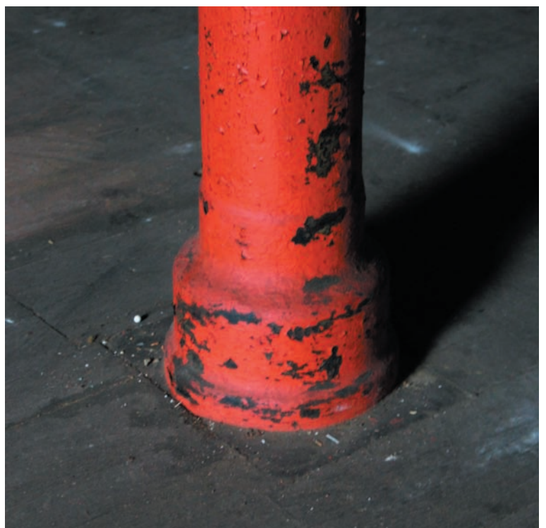
Der er i produktionsbygningernes store gennemgående rum mange eksempler på hvordan søjler indgår i konstruktionerne og rummene. Søjlernes møde med drager og gulv er artikuleret forskelligt. Alle eksempler bør registreres og indarbejdes i en restaurering.
