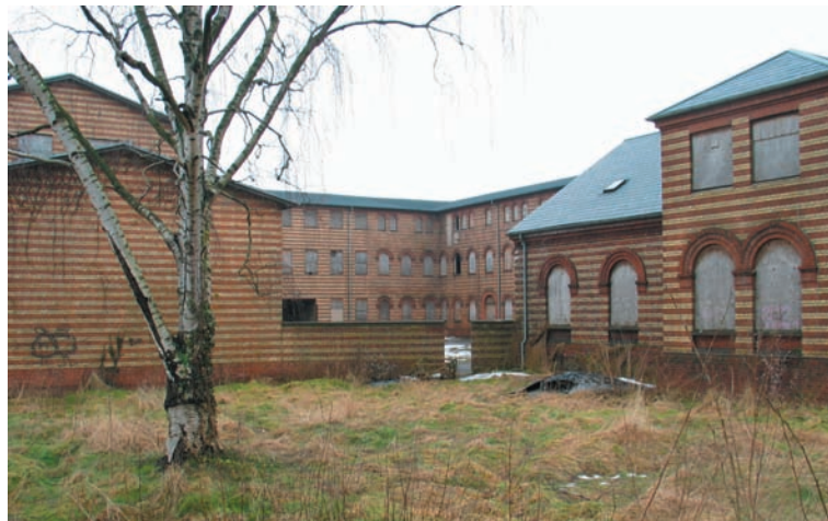
Arealet afgrænses mod det indre fabriksgårdsrum af en teglmur
