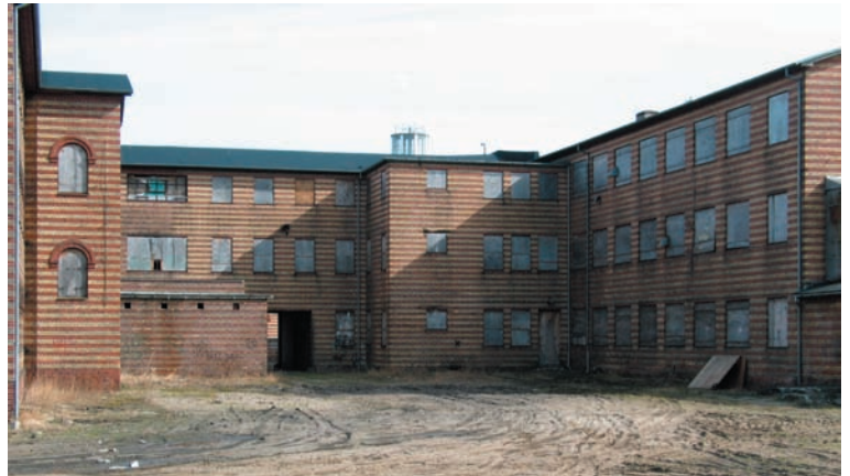
Gårdsrummet set fra sydvest
