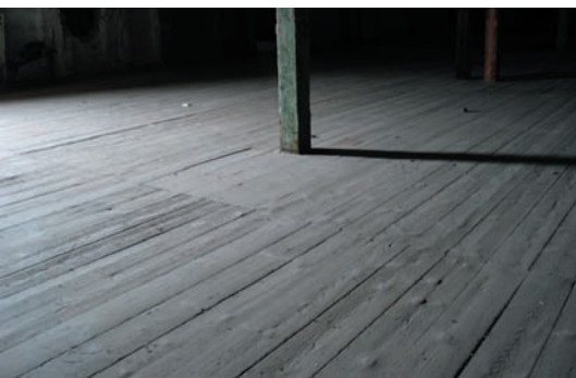
De gamle gulve er slidte og smukke, men også mange steder ødelagte og nedbrudte
