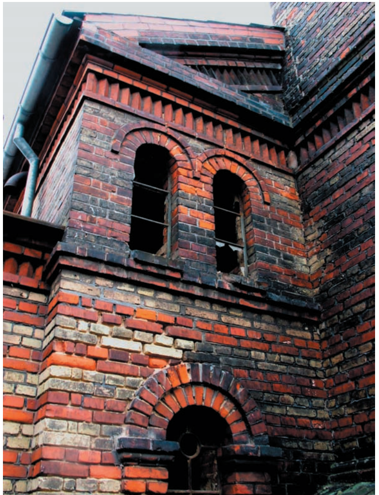
Murværksdetaljer ved gesimser, vinduer, sokler osv. er særdeles væsentlige og bevaringsværdige elementer. Mødet mellem murværk og spinkle støbejernsvinduer er ligeledes en umistelig del af anlæggets arkitektoniske karakter.
